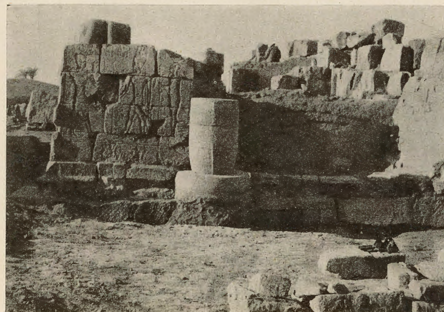
Mur nord du même édifice avant restauration.
